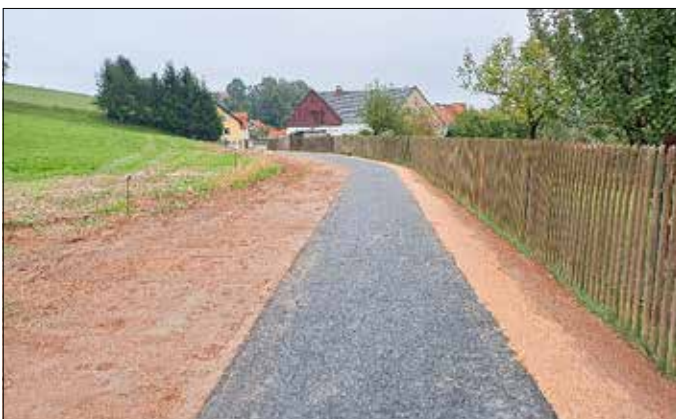
Radweg Sandmühlplatz – Am Wehr Altbernsdorf
